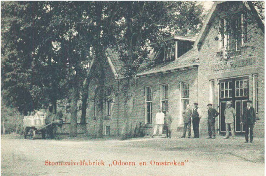
Stoomzuivelfabriek Odoorn en Omstreken 1902 (Nu studio Jop, Job Fietsen en opslag Bosbouw)
