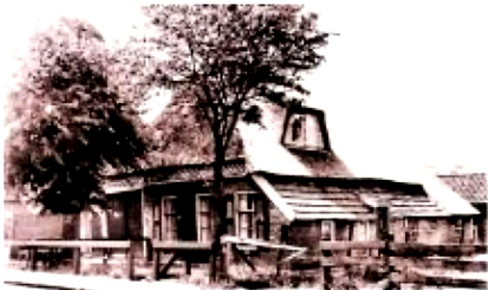
De oude kampeerboerderij aan de Hoofdstraat. Tegenwoordig is hier bistro La Finca gevestigd.
