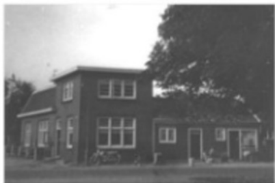
ca. 1965. Hoek Dilweg / Torenweg Woonhuis en winkel van voorheen Garage Braam, daarna Groentehandel Weerman
